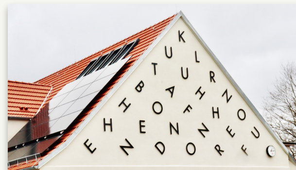
Neu gestaltete Fassade des Bahnhofs | Entwurf der Künstlerin Barbara Trautmann Foto: Nadja Felscher
